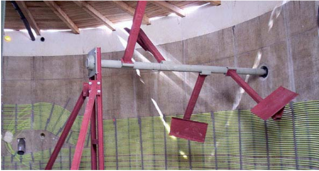
Abbildung 12: Paddelrührwerk (Quelle: FA Agrikomp)
