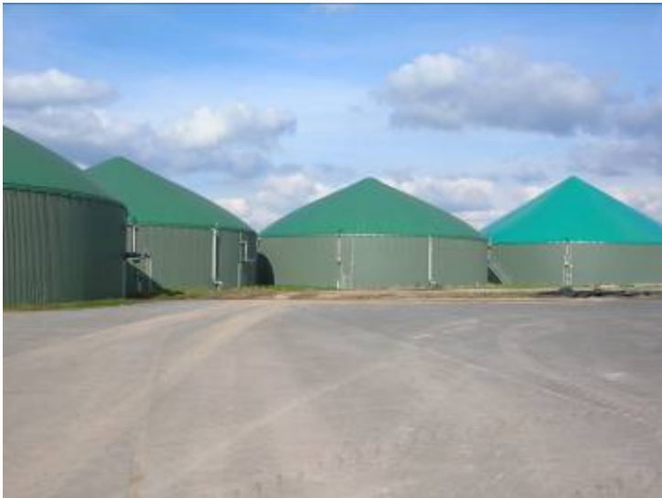
Abbildung 10: Gärstrecke bestehend aus vier Behältern
