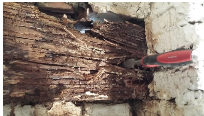
Figura 18. Acción de la pudrición fibrosa o blanca [63]
