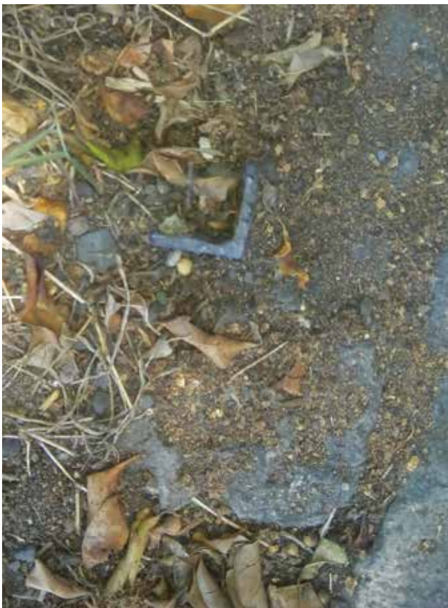
Angular con lados cortantes que sobresale tres pulgadas sobre la superficie.
