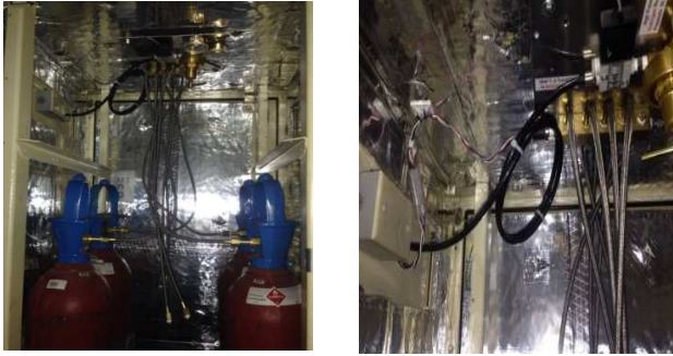
Imágenes: Instalación de Celda de combustible
