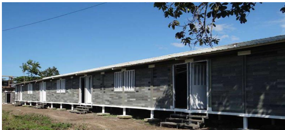
Fig. 13 Viviendas de Guapi (Cauca), con el sistema Brickarp.
