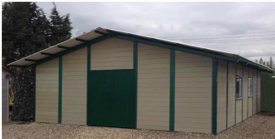
Fig. 4 Bodega de almacenamiento con muros en WPC.
