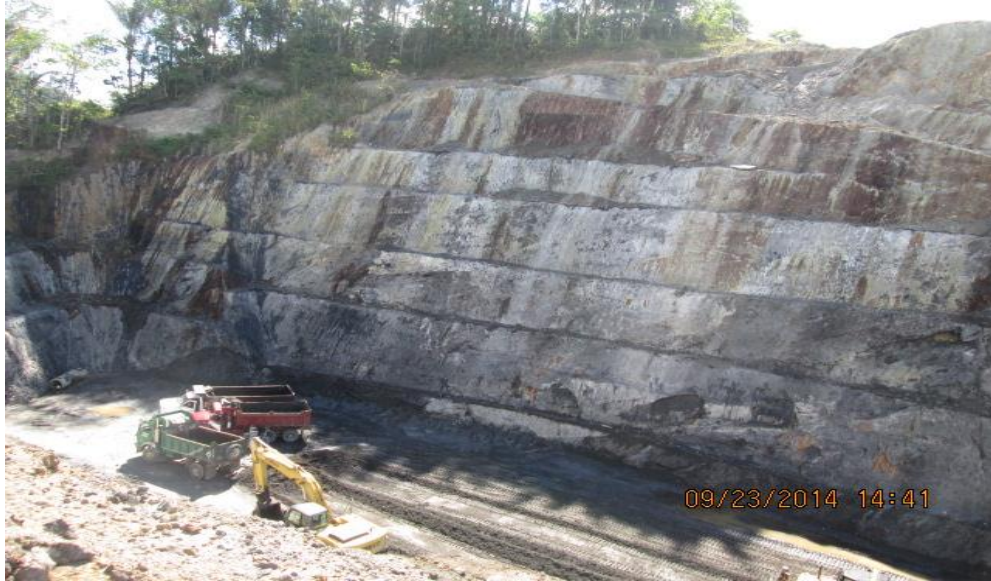
Figura 6 Frente explotación (Foto: Wilder O. Salazar, 2014). Mina de Pavas, Paujil-Caquetá
