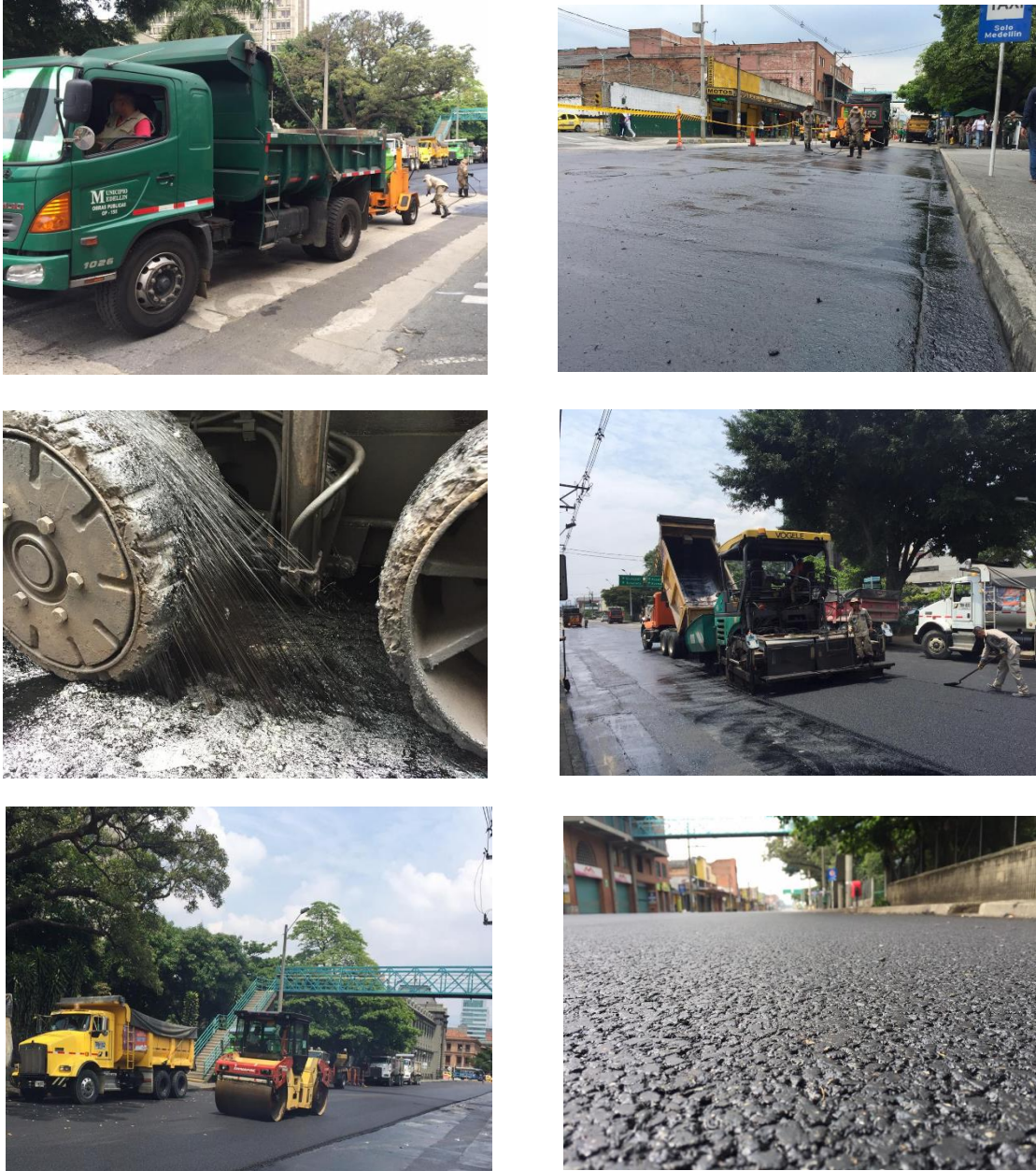
Figura 9. Registro fotográfico del proceso constructivo del tramo de prueba.
