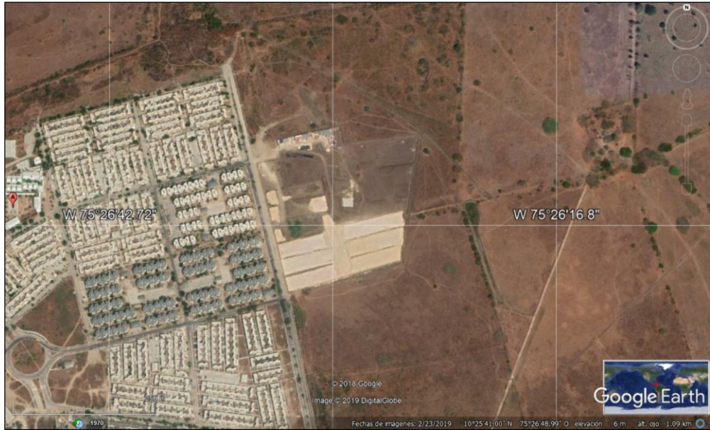
Figura 5-17 Imagen aérea del Conjunto Residencial Parque De Bolívar-Cartagena
