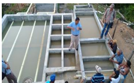
Figura 11. Capacitación en tratamiento de agua Fuente: Elaboración propia (2018)
