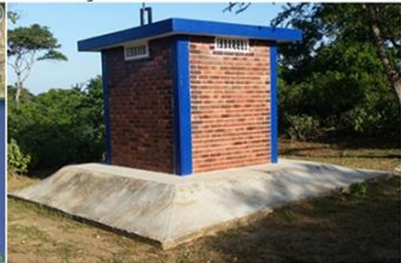
Figura 6: Caseta válvulas seccionadoras
