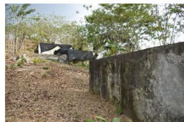
Figura 6. Agua que llegaba a las viviendas.
