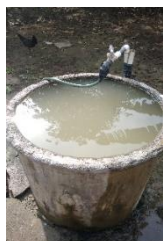
Figura 5. Planta de tratamiento antes de la optimización.
