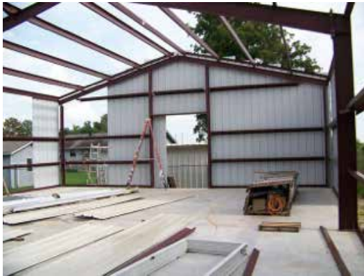
Figura 3. Construcción en estructura de acero
