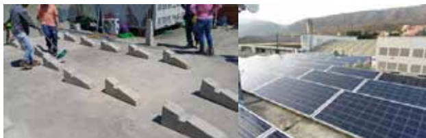
Figura 8. Instalación de los paneles
