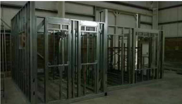
Figura 2. Proyecto de vivienda con perfilería galvanizada portante.
