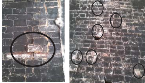
Figura 4 Descuelgue de dovelas y eflorescencias en el puente Los Libertadores Fuente: Autoras
