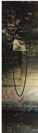
Figura 10. Separación entre el puente original y la intervención por ensanche del Puente Los Libertadores.
