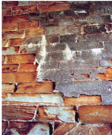
Revoco con portland en un puente de la línea ferroviaria Córdoba Málaga Fuente: (León y Goicolea, 2017, (pp.) 190-201).
