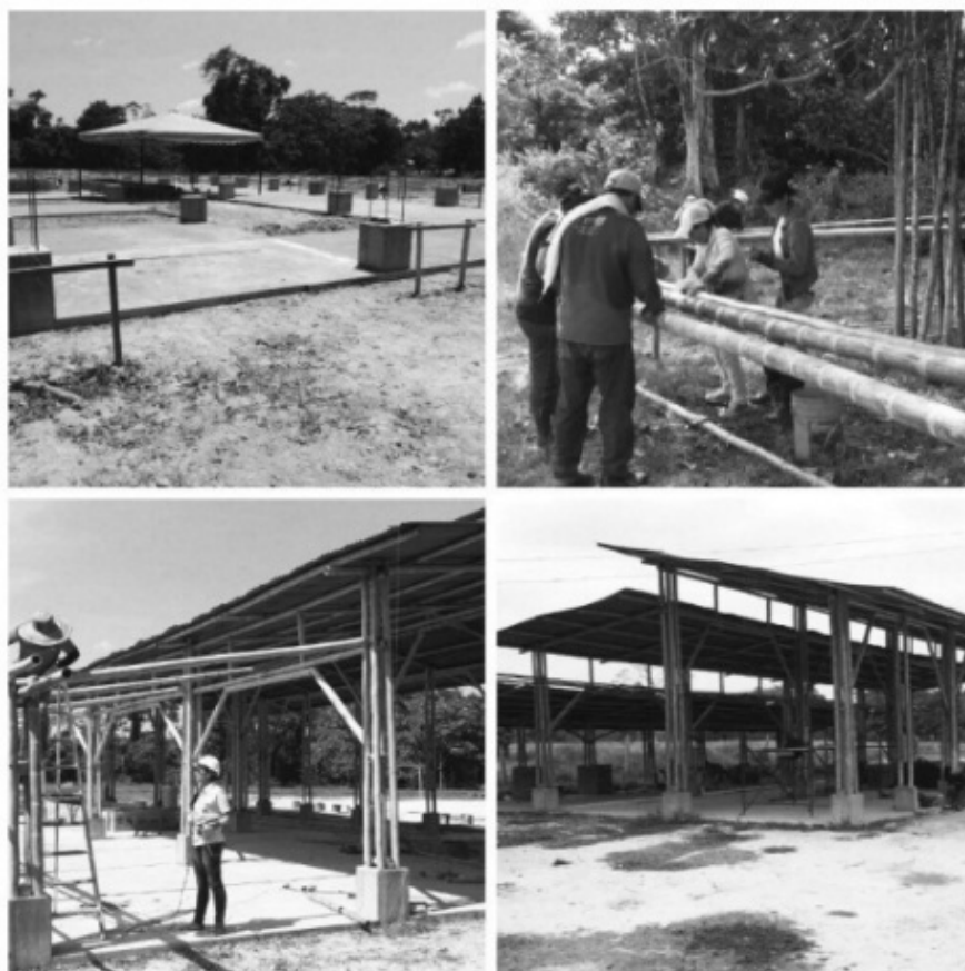
Figura 2: Construcción del taller (planta física)
