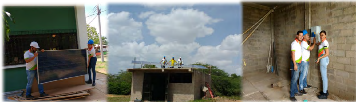
FIGURA 6. Montaje del sistema solar fotovoltaico
