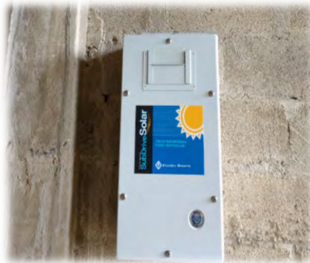
FIGURA 5. Controlador-inversor
