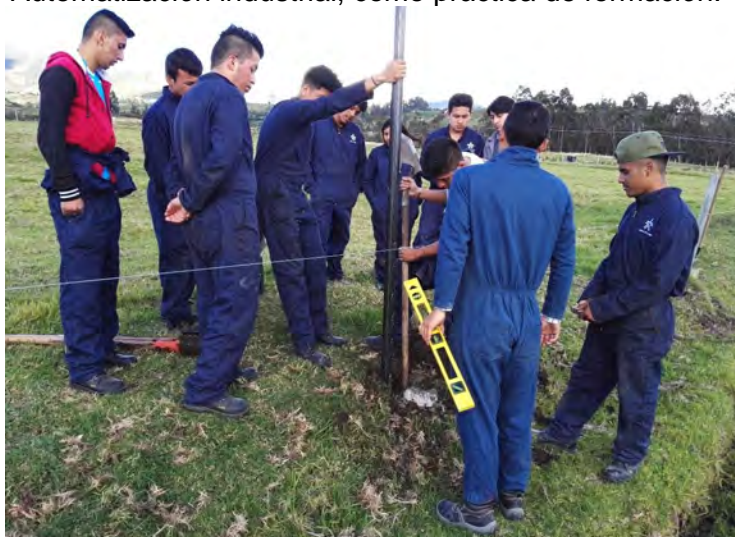
FIGURA 8. Proceso de instalación de la estación meteorológica 1 dentro de las instalaciones del CIPLL del SENA regional Nariño por parte de los aprendices de Automatización industrial, como práctica de formación.
