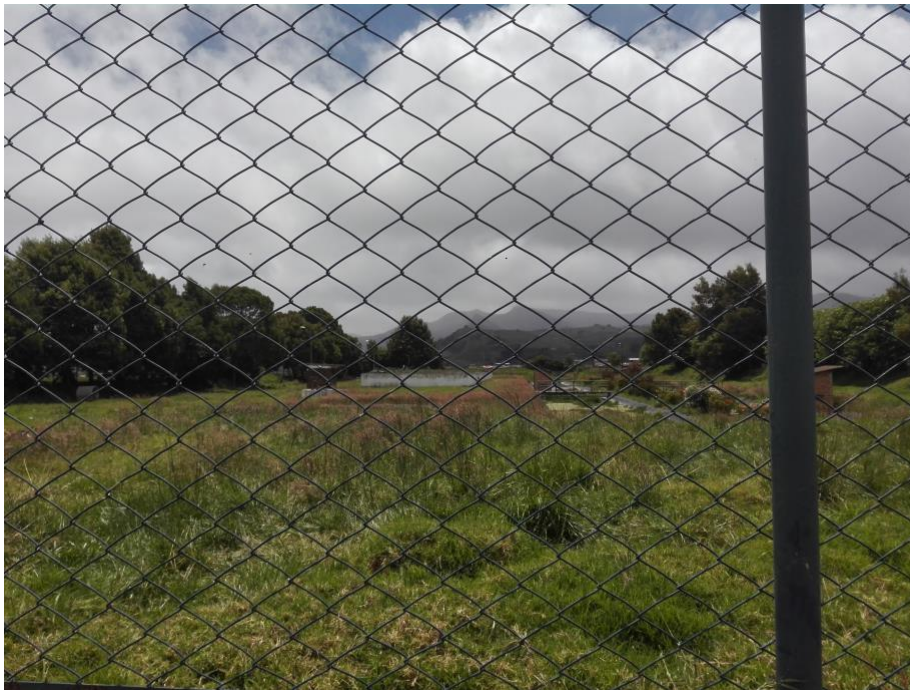
Fotografía 6 Planta de tratamiento de agua abandonada (Mancipe, 2018)
