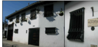
La construcción de viviendas nuevas dentro del centro histórico da pie para que aparezcan esa tipología de fachadas con ventanas y puertas que no tienen las mismas características que las fachadas tradicionales.
