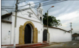
4. Cementerio Municipal San Isidro
