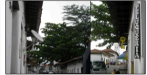
Caso Número 3: Visual interrumpida por elementos sobrepuestos en las fachadas mayormente en sectores donde se desarrolla comercio.
