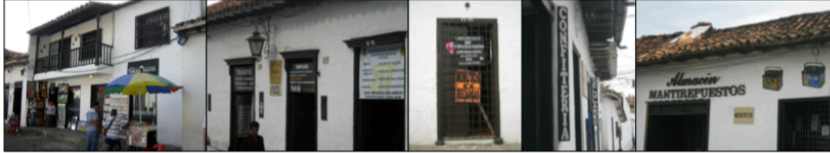
Caso Número 4: La armonía del conjunto de fachadas se ven perjudicadas por avisos publicitarios instalados sobre puertas y ventanas que en algunos casos debido a su gran tamaño ocupan un porcentaje considerable del total de la fachada, sumado a esto en zonas comerciales los productos a la venta se toman el espacio público, incluyendo la fachada y el andén.
