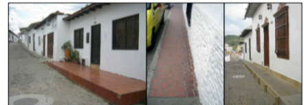
En el caso de los andenes se evidencia la reforma de muchos de estos usando nuevos materiales como la baldosa, el baldosín entre otros y en algunos casos la instalación de pequeños baldosados sobre la calle, elementos y materiales totalmente atípicos que contrastan con los tradicionales del centro histórico del municipio.
