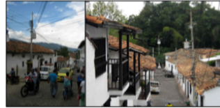
Caso Número 2: En este caso el paisaje se ve afectado por los postes de luz con cableado excesivo a la vista.
