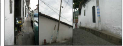
Caso Número 5: En este caso la circulación peatonal en los andenes es interrumpida por elementos de venta de productos en locales comerciales y postes de energía eléctrica ubicados sobre los andenes.
