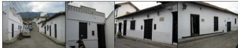
Las reformas de fachada con materiales como piedra o elementos decorativos que enmarcan puertas y ventanas no corresponden a la tipología de fachada típica predominante en el centro histórico de Girón, adicional a esto el remate superior de los muros en la fachada elaborados con calados también se presenta en algunas viviendas, este elemento además de estar elaborado en otro tipo de material al tradicional oculta el alero típico en las construcciones de la colonia.
