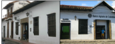
Otro de los problemas estéticos que sufre el centro histórico es la reforma de fachadas, con la utilización de piedra para los portones principales de acceso a los inmuebles, también existe el fenómeno de instalar vidrio en las ventanas en los sitios donde se usa aire acondicionado.
