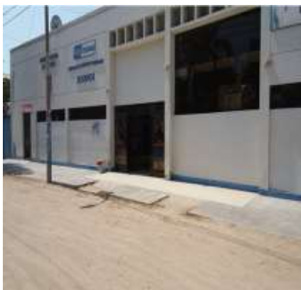
ENTRADA PRINCIPAL DEL CAP II JAYANCA
