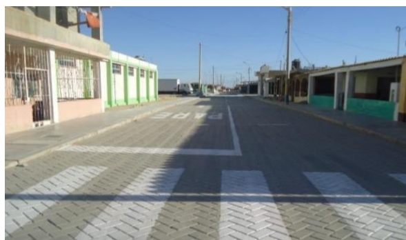
Fotografía N° 4: Saneamiento existente en el distrito el Alto
