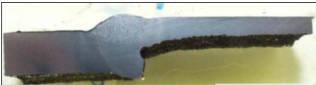
Imagen 2. Degradación por FAC y desgaste mecánico, en una soldadura de acero de baja aleación. La dirección del flujo es de izquierda a derecha, provocando su mayor efecto, aguas abajo de la soldadura. (Field Guide FAC and erosion". EPRI [13])
