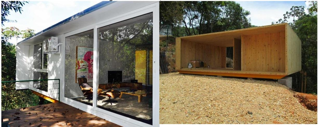
Residência feita em CLT (62m<sup>2</sup>) em 2012, execução: três dias, incluindo montagem da estrutura metálica, estrutura em CLT e colocação de caixilhos
