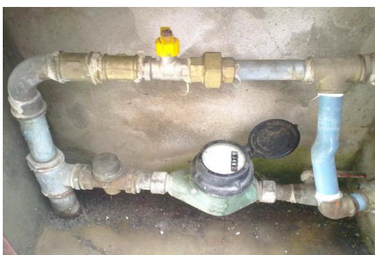
Figura 2.32 – Exemplar real de um bypass (Ribeiro, 2016)
