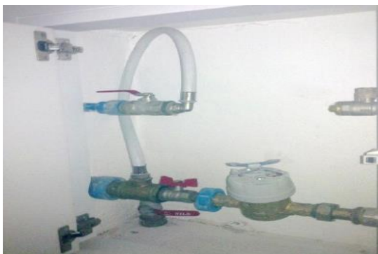
Figura 2.31 – Exemplar real de um bypass (Ribeiro, 2016)
