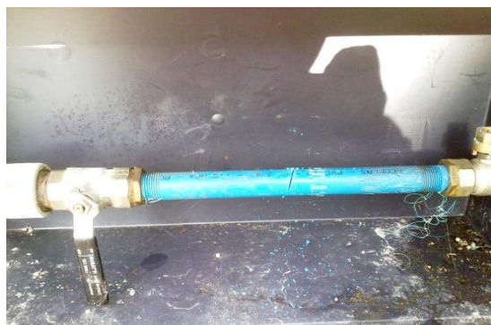
Figura 2.30 – Ligação ilícita real, nomeadamente uma ligação direta (Ribeiro, 2016)
