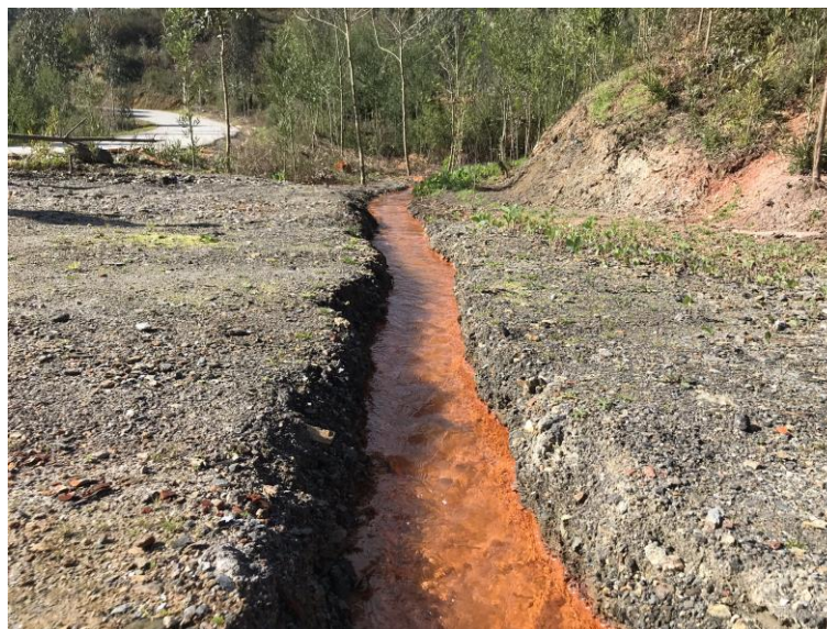
Figura 28 - Depósito de cor ocre no fundo do canal de escoamento da galeria A2.
