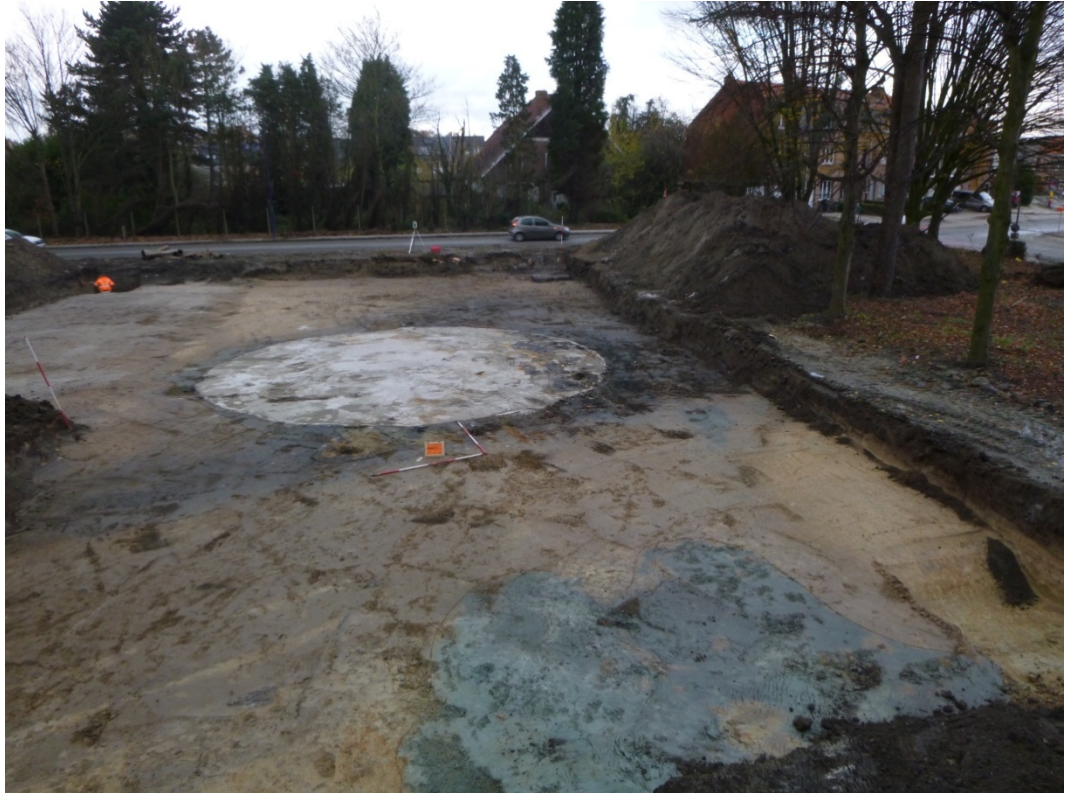
Afb. 5.2. Zicht op het uitgegraven bufferbekken met centraal de verstoring door het vroegere plantsoen/vijver.
