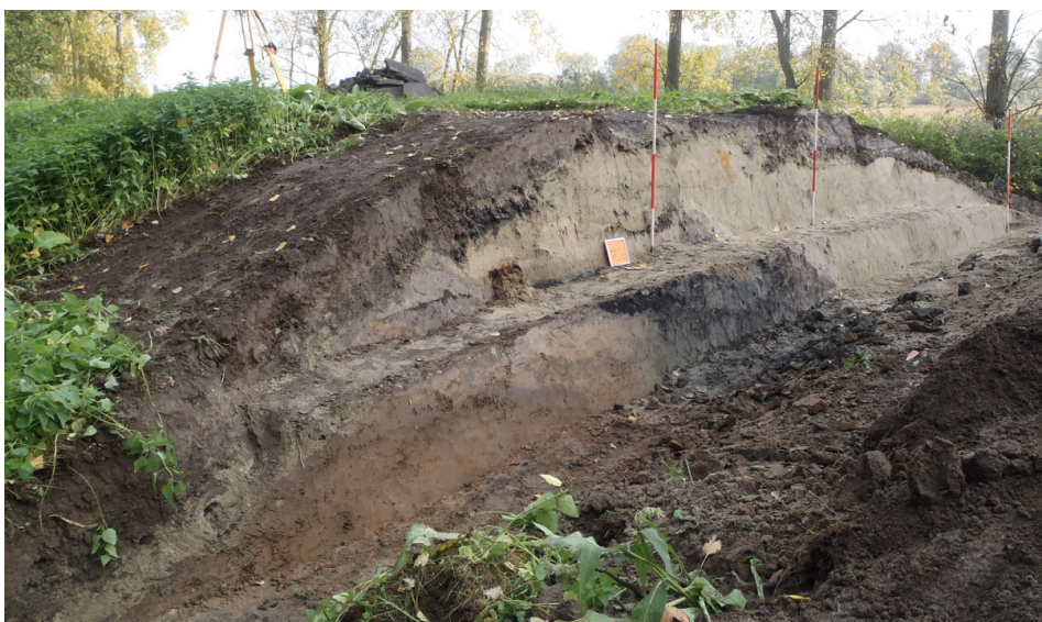
Afb. 81. Dijkdoorsnede locatie Grote Wal, de toekomstige overlooppdijk.
