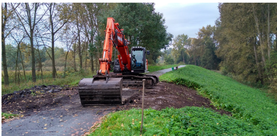
Afb. 78. Het verwijderen van de asfaltlaag.
