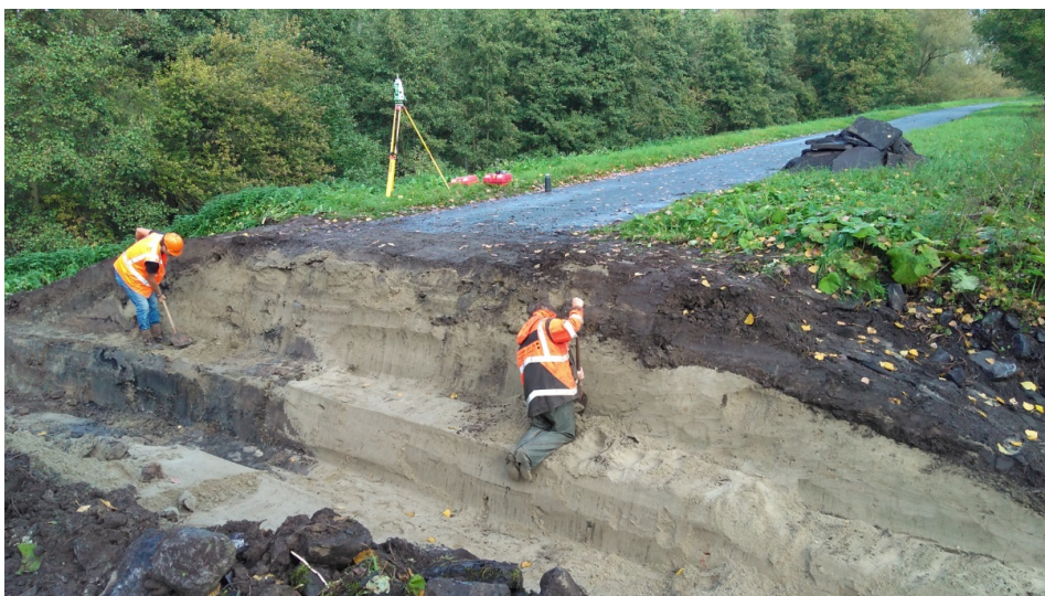
Afb. 80. Het schaven van het 18 m brede noordelijke wandprofiel van de toekomstige overlooppdijk Grote Wal, waar dikke lichtgrijze zandlagen opgeworpen zijn tegen een westelijke kleinere kleidijk (links in beeld).
