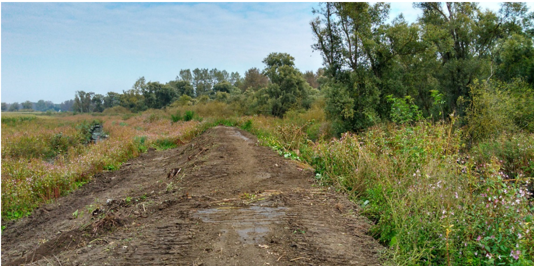
Afb. 84. Het vrijmaken van het werkvlak op de zomerdijk, sfeerbeeld.
