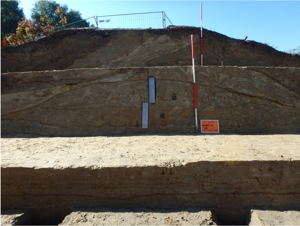
Afb. 70. Detail van de oudste fase van de dijk, met pollenbakken en OSL-buizen.
