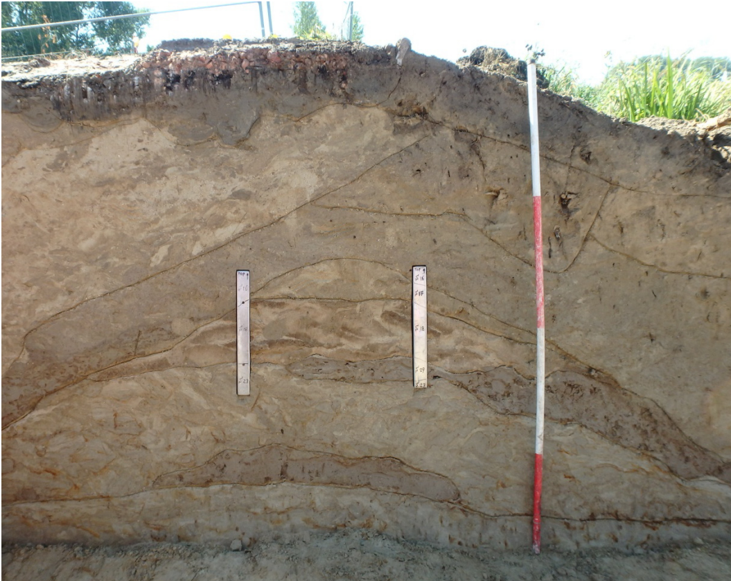
Afb. 71. Detail van de oudste fase van de dijk met pollenbakken ter hoogte van de plaggenophoging.
