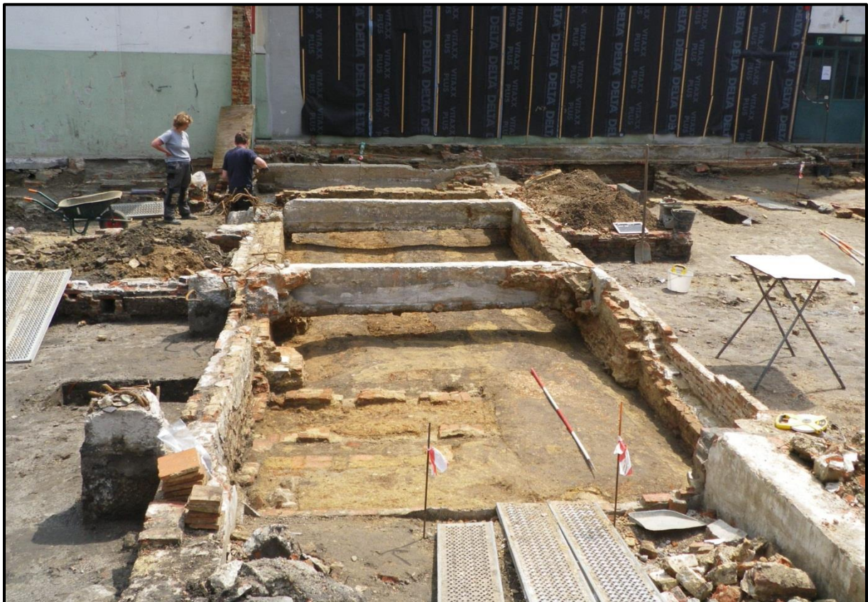
Figuur 1.16: Overzicht niveau 2B, middelste gedeelte, gezien vanuit het westen
