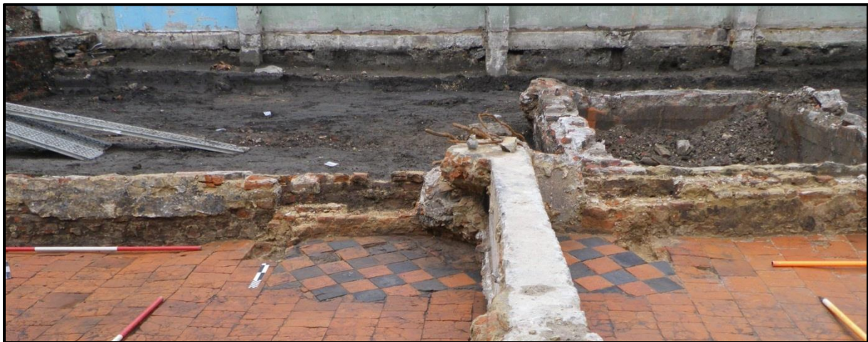
Figuur 1.14: Overzicht niveau 2A, noordelijk deel, gezien vanuit het zuiden
