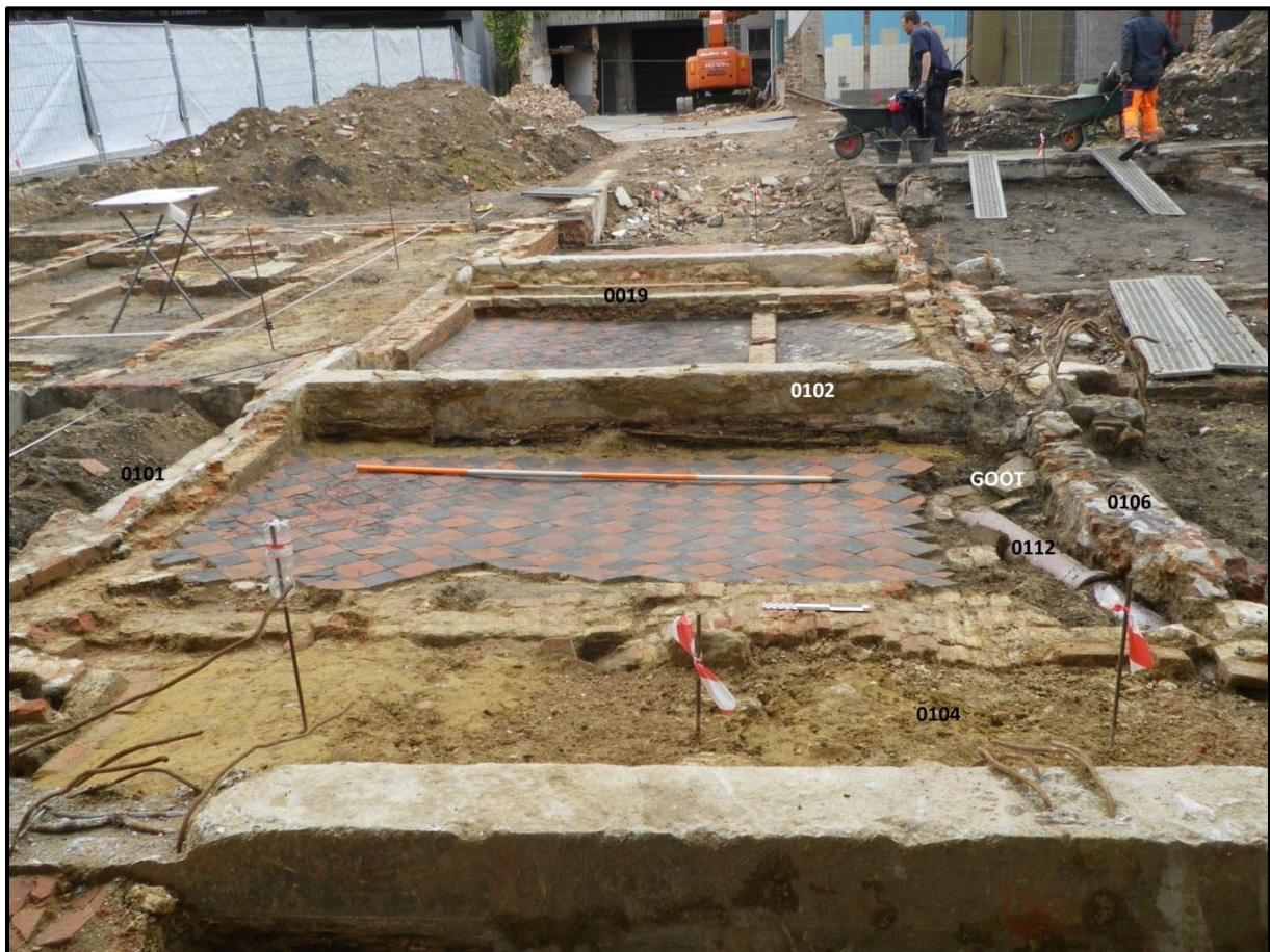
Fig. 3.127: Zone C niveau 1, overzicht van een aantal betonbalken en goten/rioleringsbuizen
