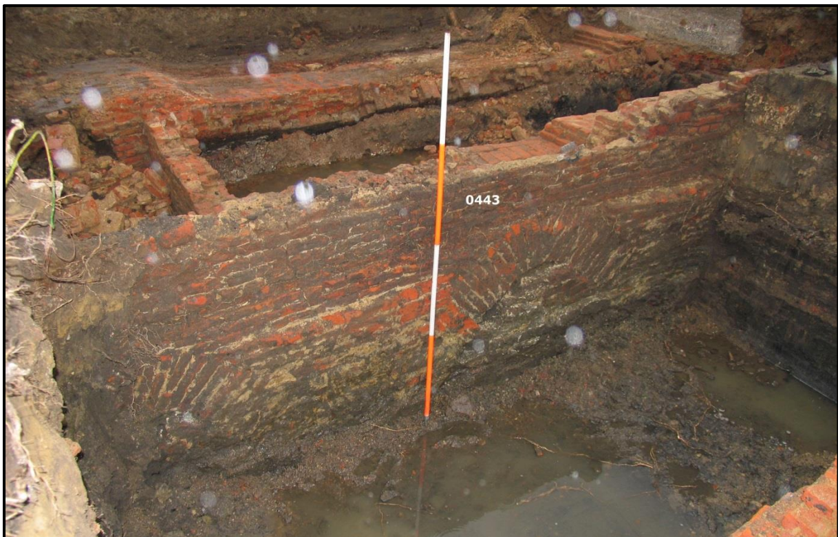
Fig. 2.27: Middeleeuwse muur (0443) met vrij spitse grondbogen (achteraf dichtgemetseld)
