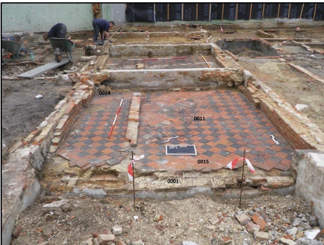
Fig. 3.118: Zone C niveau 1, achtergevel 0001
