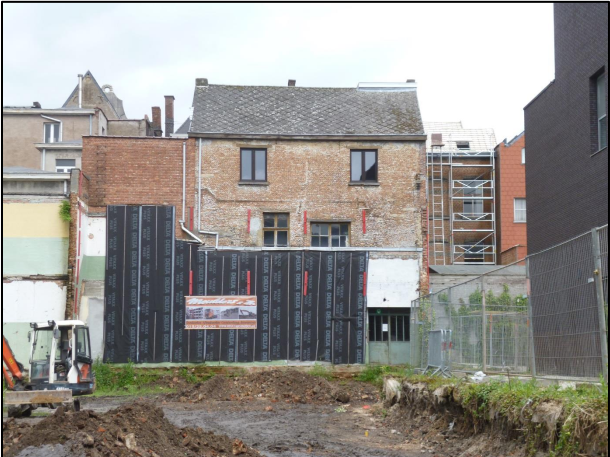
Fig. 2.20: Zicht op het achterhuis van 0584, gezien vanuit de Begijnenstraat
