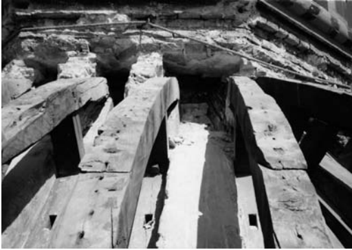
Figura 13 Detalle de unión con el ochavo de madera superior.
