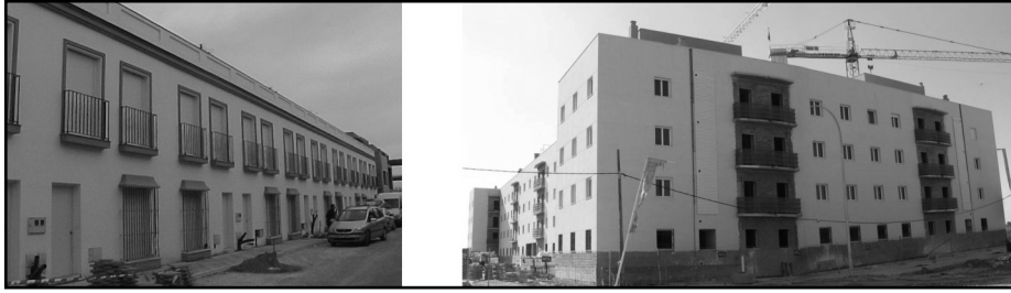
Figura 3. Imágenes ilustrativas de los modelos de construcción habituales en Sevilla, MCH 1 y MCH 2 . Figure 3. Common Constructive Model in Sevilla, illustrative images, CCM 1 y CCM 2 .
