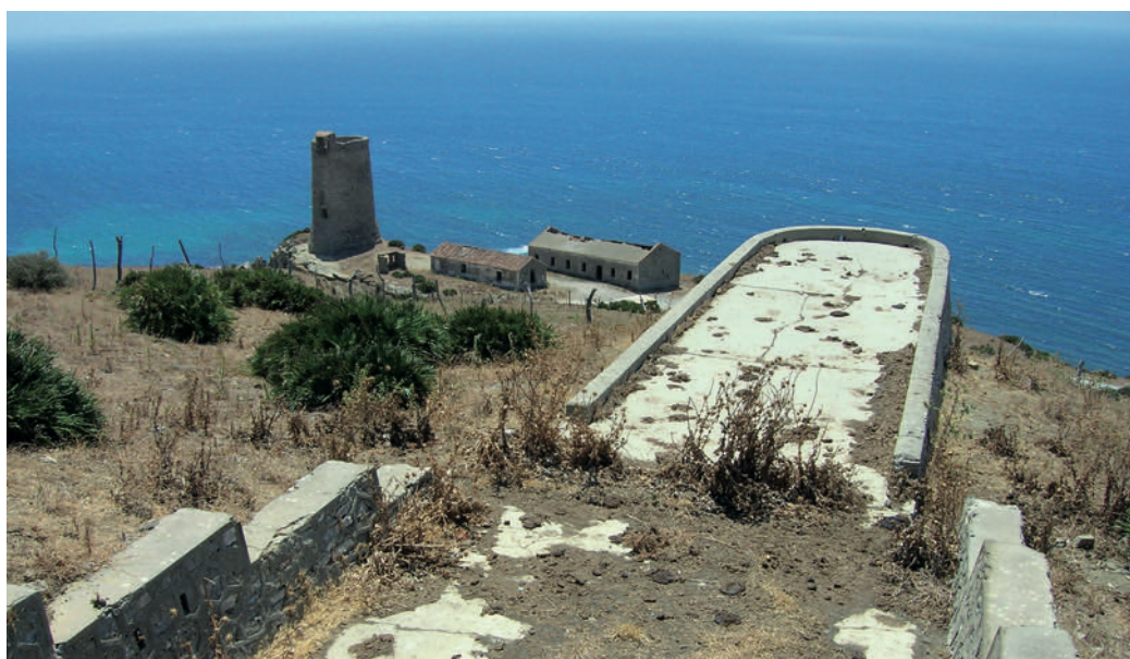
Figura 05: Torre de Guadalmesí. Junto a la desembocadura del río Guadalmesí, término municipal de Tarifa, en el Parque Natural del Estrecho. Torre almenara similar a la Torre Nueva o a la Torre Carboneras, vista desde un refugio para proyector de iluminación. Los proyectores, colocados en lugares estratégicos, perseguían iluminar el Estrecho de Gibraltar por la noche para que la artillería pudiera fijar los objetivos navales en todo momento. Federico Arévalo Rodríguez, 2005
