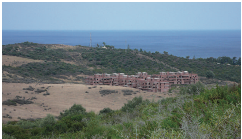
Figura 03: La urbanización en soledad. Fotografía de la Obsolescencia, Costa Casares, 2014. Jorge Izquierdo Cubero
