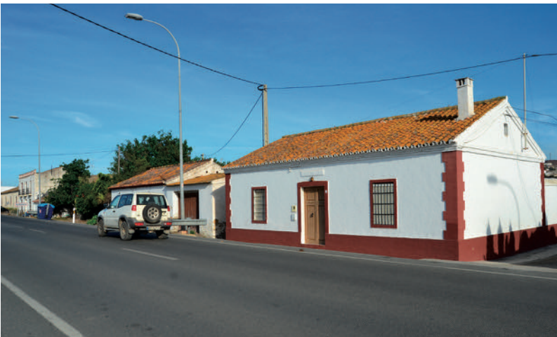
Figura 06: Casilla de peones camineros sin alterar en las proximidades de Torredelmar
