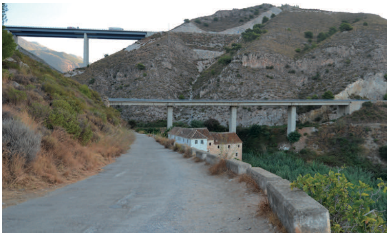
Figura 03: Junto a la antigua carretera de la costa restos de arquitectura industrial (Molino de Papel, en Nerja). En segundo término rectificación del trazado con puente de los años 1970 y al final la moderna autovía A-7
