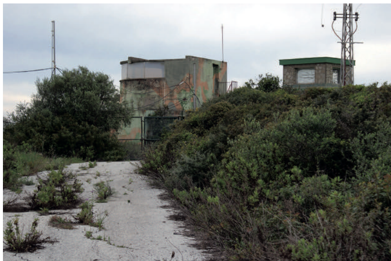
Figura 04: Puesto de mando de la batería de Guadiaro. Club de golf de la Alcaldesa, entre La Línea de la Concepción y San Roque. Edificio sin uso perteneciente a la parcela delimitada por el club de golf. Alberto Atanasio Guisado, 2015
