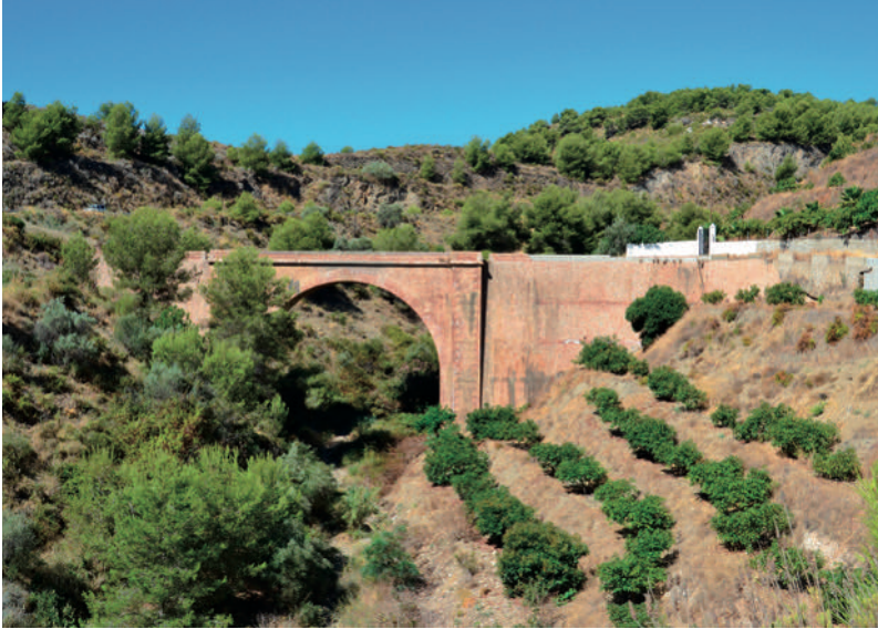
Figura 05: Uno de los viaductos gemelos de Maro, en un tramo aislado de la antigua carretera de la costa junto a Nerja
