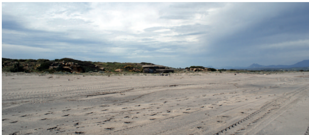
Figura 01: Búnker IA28. Playa de Punta Mala, San Roque. Búnker en dos niveles para dos ametralladoras y un anticarro, construido como prolongación de la ladera que baja hasta la playa. Alberto Atanasio Guisado, 2015
