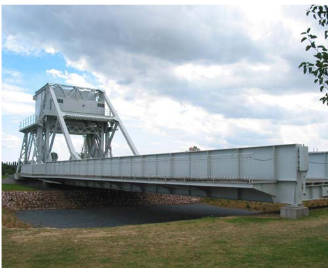
Figura 11. Puente Pegasus antiguo trasladado a su ubicación actual, "en seco", sobre un río figurado. Fotografía: https://es.wikipedia.org/wiki/Puente_Pegasus#/media/File:PegasusBridge_museum.JPG
