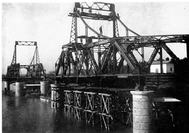
Figura 4. Vista del puente en construcción. Fotografía: Historia gráfica del puerto de Sevilla . (p. 59)
