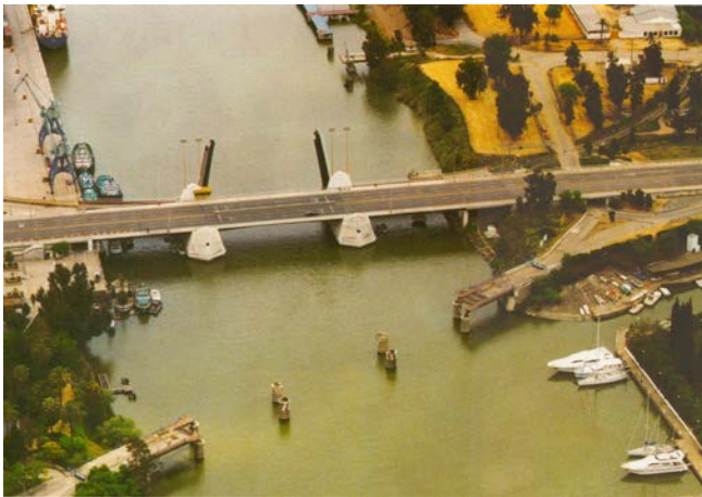
Figura 6. Vista del puente desmontado junto al nuevo puente de las Delicias. Se aprecian todavía las pilas antes de su voladura, primeros tramos y estribos. Los puentes sobre el Guadalquivir en Sevilla. (p. 119)
