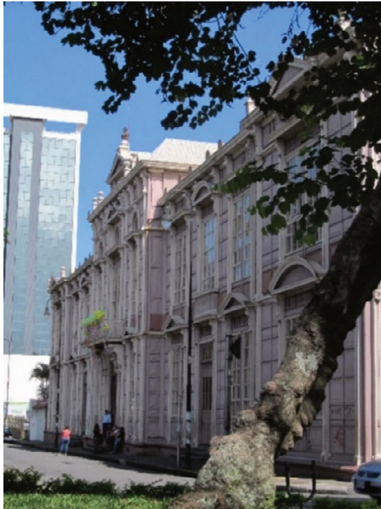
Figura I-16: Escuelas Graduadas, conocidas como Edificio Metálico. Es una estructura traída desde Bélgica e inaugurada en 1896. Fotografía: Rosa Elena Malavassi Aguilar, 2017
