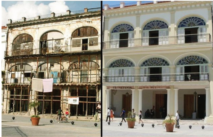
Figura 30: Rehabilitación del edificio San Ignacio, La Habana. Fuente: http://www.arquitecturacuba.com
