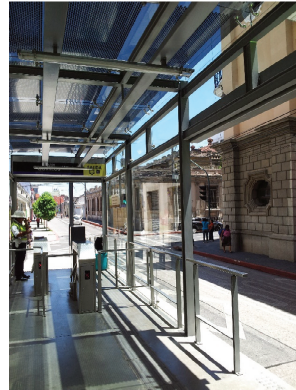
Figura 24: Estación del Transmetro en el Centro Histórico de Ciudad de Guatemala.
