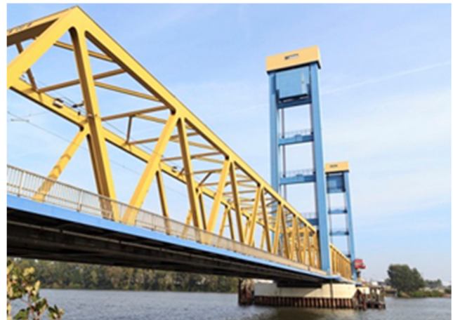
Fig. 2. Kattwykbrücke Bridge in Hamburg [33].
