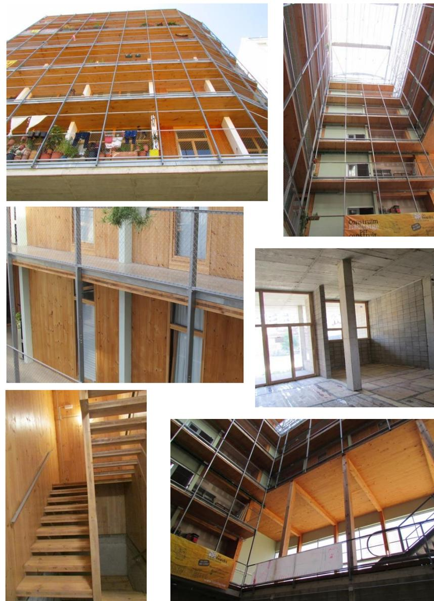
Fig. 16 Imágenes que muestran los elementos de prefabricación industrializada
