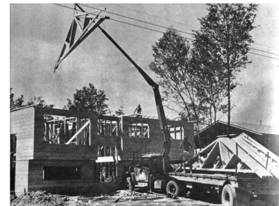
Fig. 3 Montaje de casa en Estados Unidos con sistema tipo Ballon frame. Recuperado de Industrialización de la construcción. Chemillier P. (1980).
