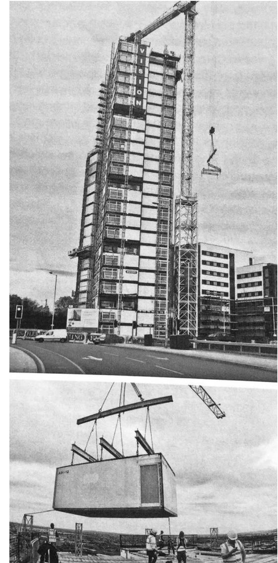
Fig. 4 Montaje de módulos 3D en edificio de 24 plantas en Reino Unido (27 semanas)
