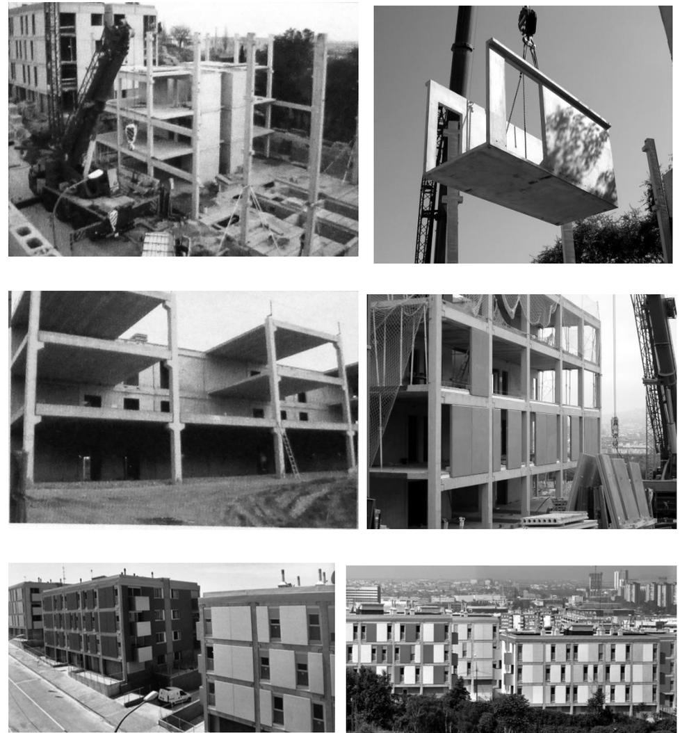
Fig. 14 Imágenes de proceso de montaje y ensamblaje, en estas se destaca el izado de los módulos tridimensionales.
