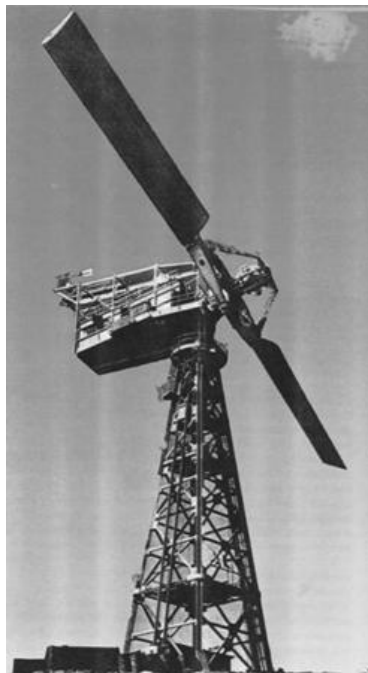
Ilustración 1: Primera instalación eólica que supera 1 MW en 1941 (Fuente: energy.kth.se)
