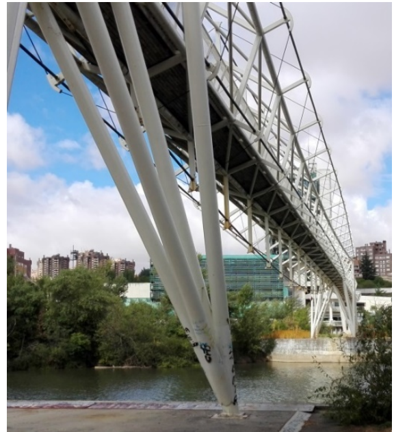
Figura 2. Pasarela del Museo de la Ciencia. Vista del vano 3.
