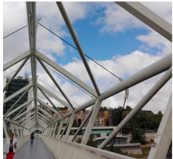
Figura 3. Pasarela del Museo de la Ciencia. Detalle del pretensado perimetral en el vano 3.
