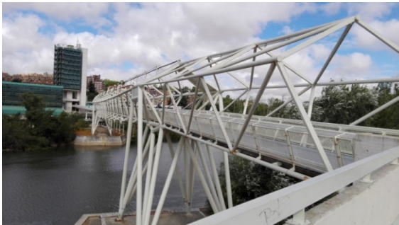
Figura 1. Pasarela del Museo de la Ciencia. Vista general.
