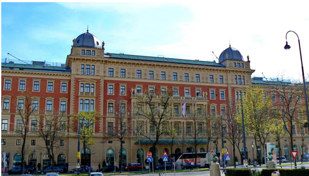
10. kép. Schottenring Komplex, illetve Palais Hansen Bécsben.
