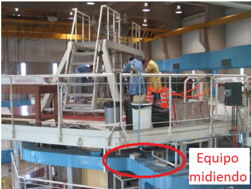
(a) Boca de tanque del RA-6 con el equipo midiendo
