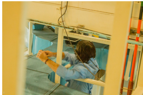
(b) Instalación final
