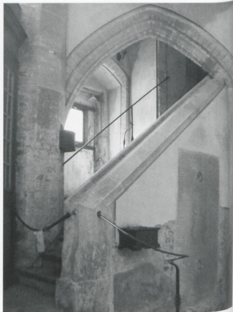
12 Görlitz, Treppenanlage zur Empore der Dreifaltigkeitskirche (Foto: S. Bürger)
