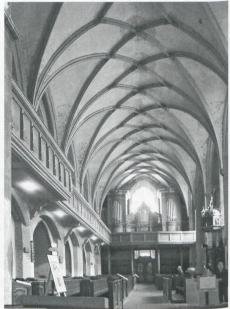
2 Görlitz, zweischiffiges Langhaus der Dreifaltigkeitskirche mit Blick nach Westen (Foto: S. Bürger)
