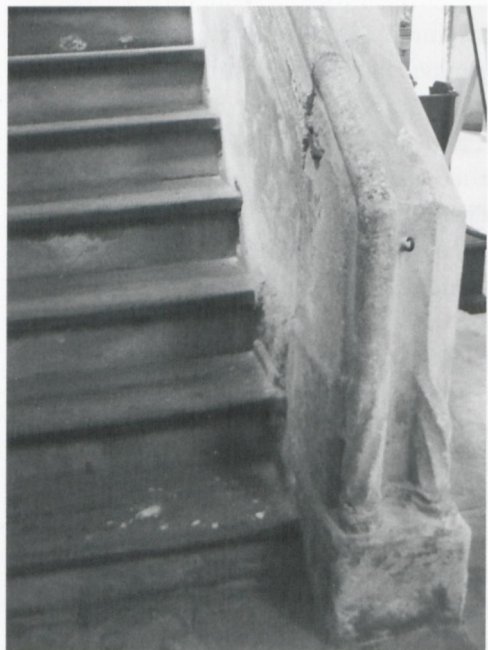
13 Görlitz, Barbarakapelle, Handlauf der Treppenanlage (Foto: S. Bürger)
