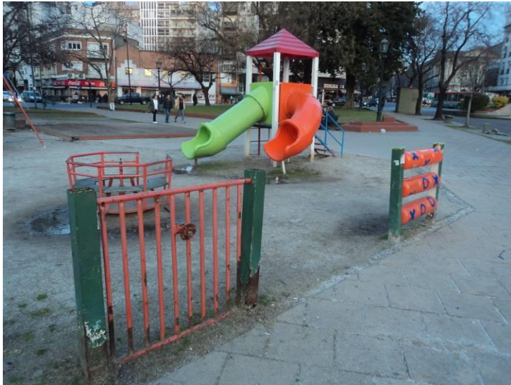
Figura 20: Plaza Italia: se pueden observar dispositivos lúdicos categoría Otro (volante) y Calesita en estado Malo, por ausencia de funcionalidad y presencia de óxido. A su vez, se observa erosión en todo el ámbito con presencia de encharcamientos que dificultan su uso.
