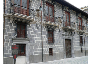
Figura 2. Vista de la fachada del actual edificio de la Madraza. Fotografía de M.ª Elena Díez Jorge
