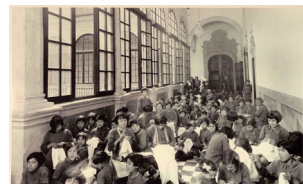
Figura 12. Galería alta del Patio de la Capilla del Hospital Real de Granada. Desde el siglo XIX, en los pisos superiores, se establecieron los dormitorios de las ancianas y de las niñas y su escuela, donde recibían también formación de labores del hogar. Fotografía del Archivo de la Diputación de Granada, 1927-1934. http://biblioteca.ugr.es/pa-ges/bibliotesoros/saber-mas/_img/10/!/?thumb/700 , consulta 30-03-2016.
