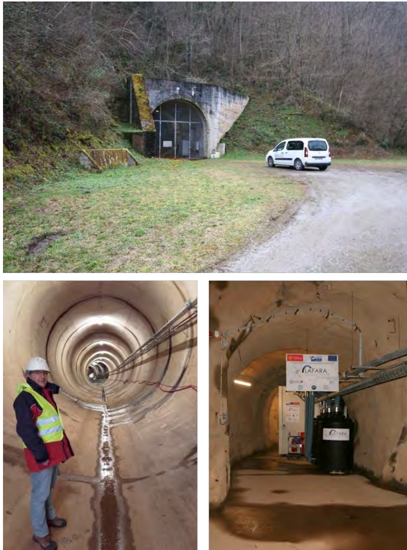
Figure 3.5 : Photos représentant l'entrée du tunnel, et l'intérieur du tunnel (à l'entrée et devant le préfabriqué accueillant les détecteurs à partir de 2016)
