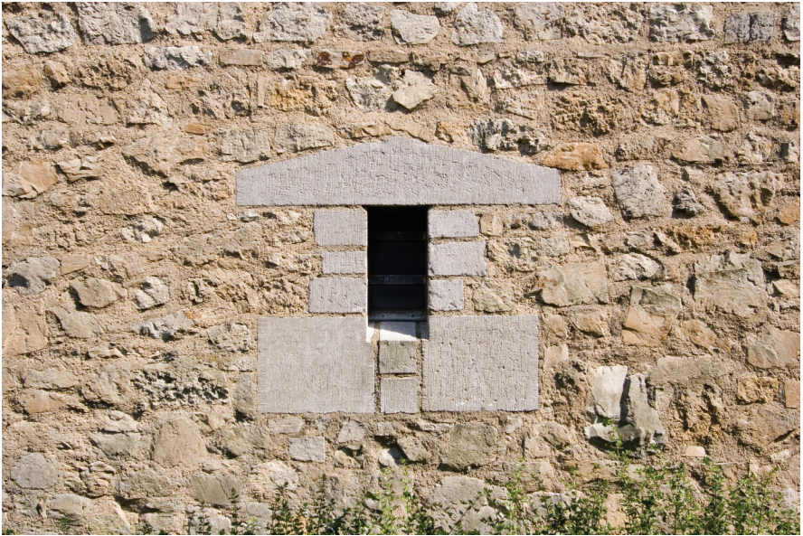
Außenwände des Fensters im Vorbau
