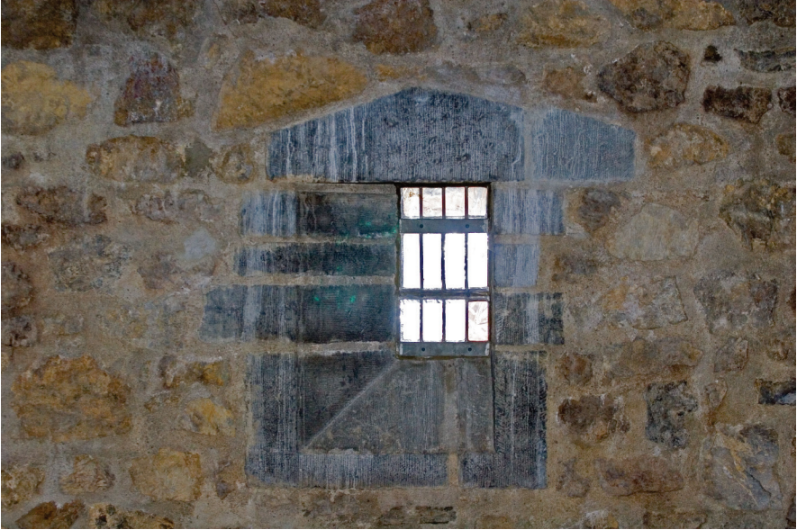
Innengewände des Fensters im Vorbau
