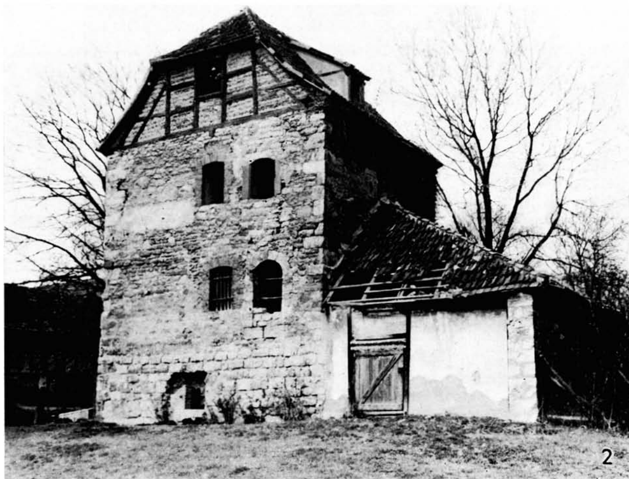
1: „Weiherhaus“. Motte mit Fachwerkturm und Wassergraben bei St. Johannis in der Nähe von Nürnberg. Zeichnung von Albrecht Dürer um 1495; — 2: Die „Käseburg“. Turm und Anbau auf einer Motte am Ortsrand von Brüheim, Kr. Gotha.
