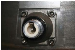
Bild 2.1-1: Messanschluss einer Durchführung, aus [Vol12]
