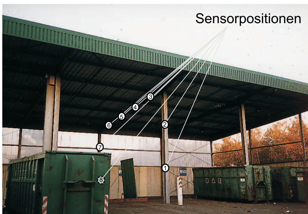
Abbildung 22: Halle mit Sensorpositionen
