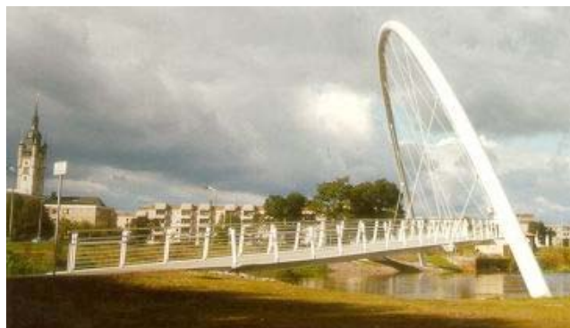
Abbildung 2: Referenztragwerk Fußgängerbogenbrücke über die Mulde in Dessau
