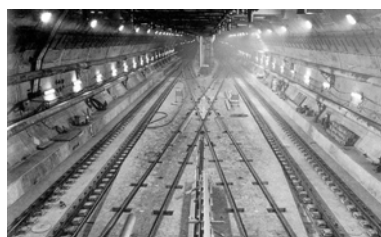
Abbildung 2: Bau des Eurotunnels
