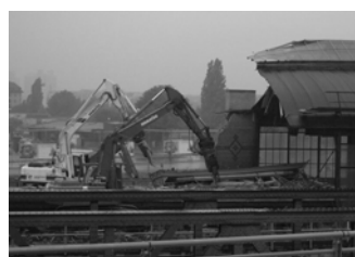
Abbildung 1: Umbau des Lehrter Bahnhofs
