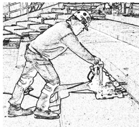
Bild 7 Kleinmechanisierung beim Horizontalbohren in Beton mit Bosch-Bohrhämmer GBH 3-28 E (nach <http://www.bosch-presse.de/>)
