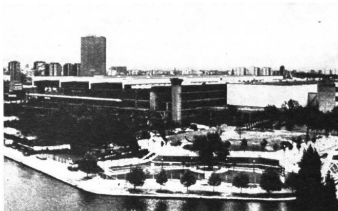
1 Der Schlachthof von La Villette in Paris vor der Umnutzung
