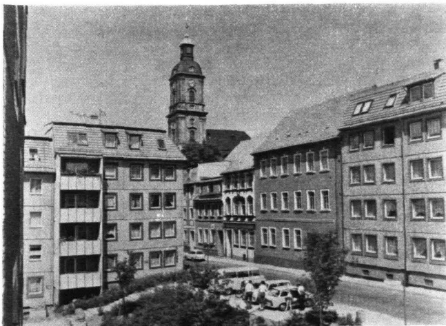
1 Rekonstruktion und Neubau bei der Umgestaltung des Stadtkernes in Gera. 1984
