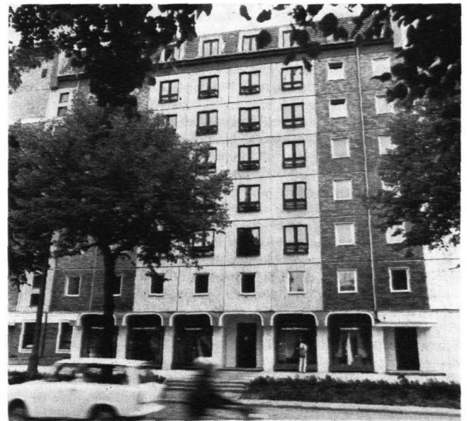
4 Berlin. Wohnungsbau in der Wilhelm-Pieck-Straße.
