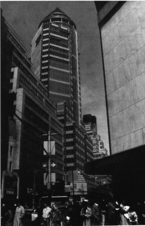
3 Mit dem zahllosen Bau von Büro-Hochhäusern – hier 750 Lexington Avenue in New York – wird Wert gelegt auf ein ambitioniertes architektonisches Erscheinungsbild
