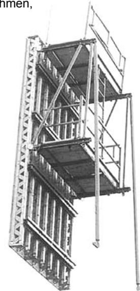
Abb. 3.8 Trägerschalung: PERI-VARIO-Holzschalung mit horizontaler Gurtung<sup>8</sup> (quer zu den H20-Trägern);
