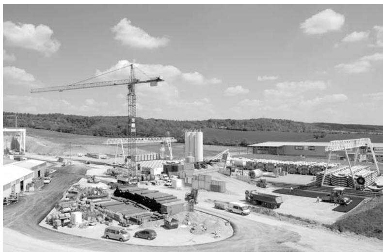
Abb. 5.7 Baustelleneinrichtung mit Feldfabrik für die Tübbingvorfertigung am Finnetunnel im Jahr 2008, WAYSS & FREYTAG Ingenieurbau AG (Foto: M. WILLE)
