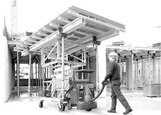
Abb. 3.10 Versetzen eines vorgefertigten Schaltisches mit Hubwagen und Spezialgerät (DOKA)
