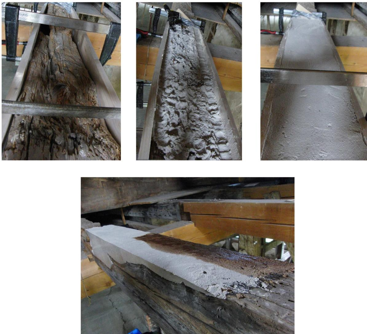
**Abbildung 52: Stufen der Reprofilierung eines Holzbalkenabschnittes mit Holzergänzungsmörtel**
